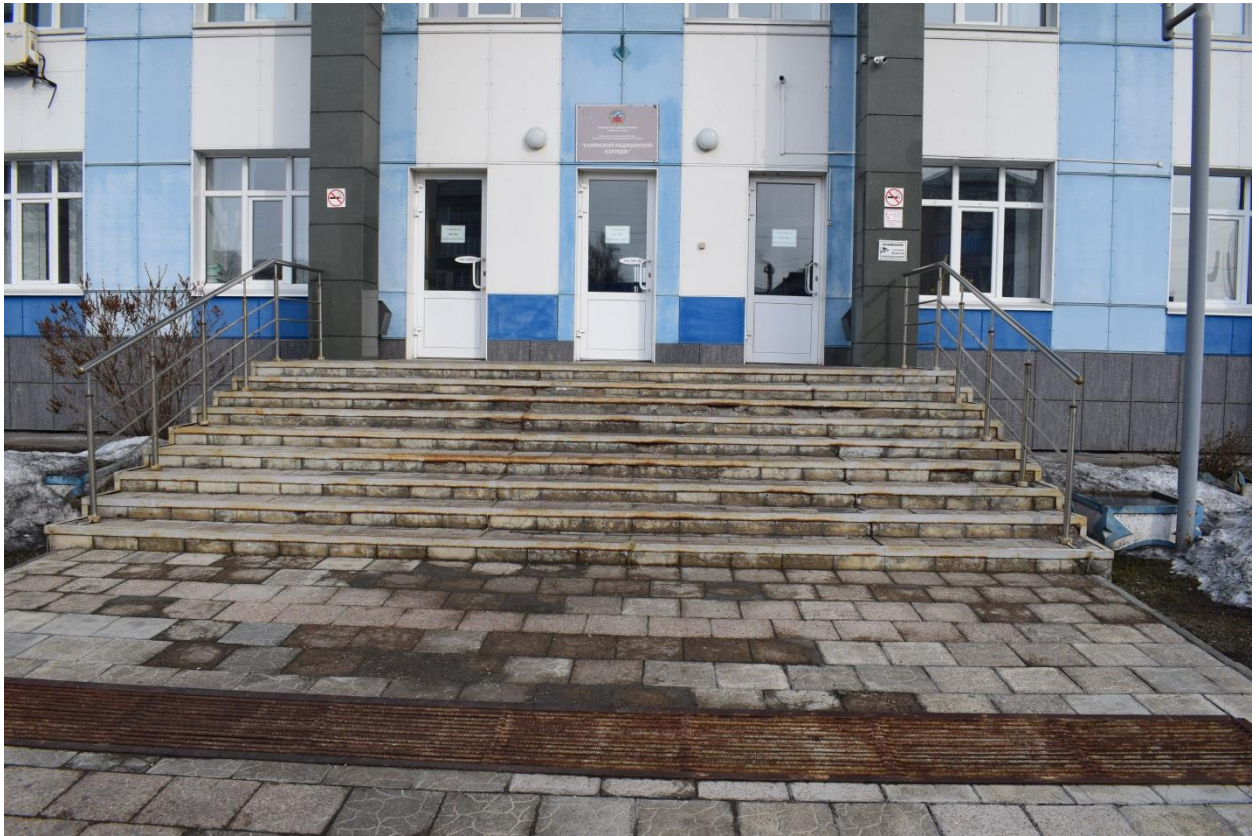
Фото №3: Главный вход в здание
